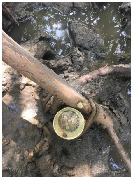
Figura 8: Implantação dos marcos geodésicos com a referência nas áreas de coleta do PMBA.
